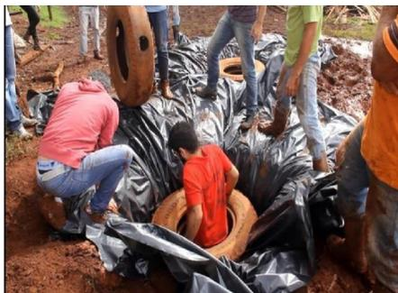
**Figura 3e:** Vedação com lona na parte superior após inserção dos pneus
