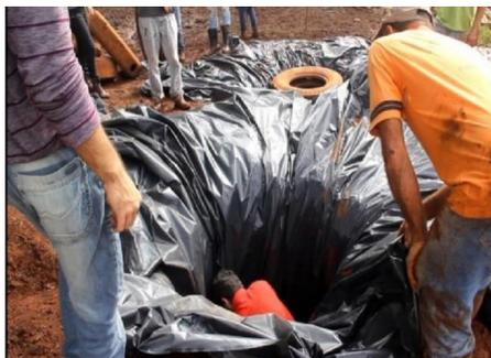
**Figura 3d:** Preenchimento dos buracos com pneus
